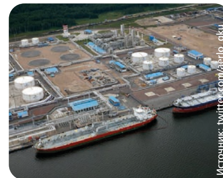
Морской терминал НОВАТЭК Усть-Луга. Системы дозирования, генераторы пены, лафетные стволы, вышки. Заказчик: НОВАТЭК
