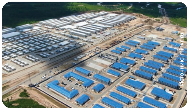
Амурский ГПЗ. 1. Система пенного пожаротушения (баки-дозаторы), генераторы высокократной пены, пенообразователь. Заказчик: НИПИ НГ «Петон», Linde. 2. Оросители и генераторы пены, система дозирования, пенообразователь. Заказчик: Текнимонт (Италия)
