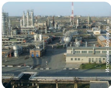
Орский НПЗ. Комплексы пожарного оборудования. Заказчик: Электроснабсбыт, Орскнефтеоргсинтез.
