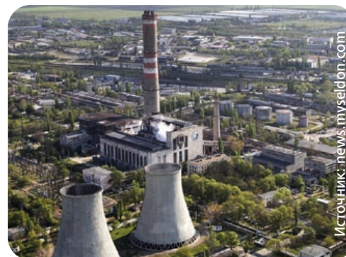
Симферопольская ГЭС. Комплексы пожарного оборудования, системы хранения и дозирования, пенообразователь. Заказчик: ИНТЕРЭНЕРГО
